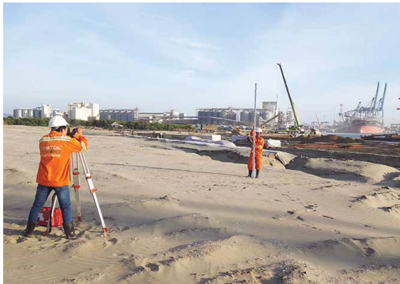
Công tác đo đạc tại hiện trường
