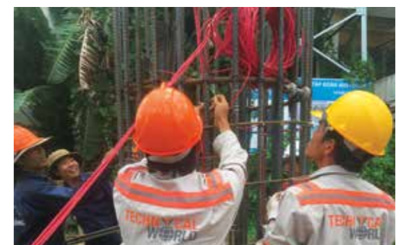
Thí nghiệm đo ứng suất và biến dạng co giãn trong thân cọc
