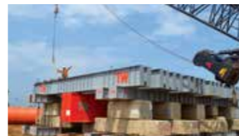
Lắp dầm phụ & tăng đỡ neo
