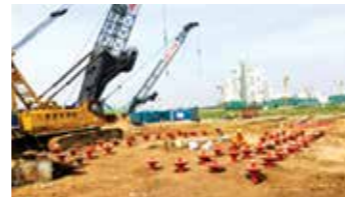
Lắp đầu chụp neo
