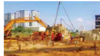
Thi công xoắn neo
