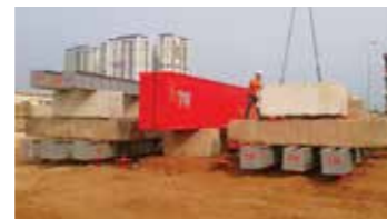
Lắp dầm kê, gối tải và dầm chính
